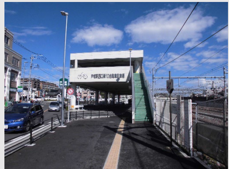
建物式駐輪場 (戸塚駅西口第10自転車駐車場)
