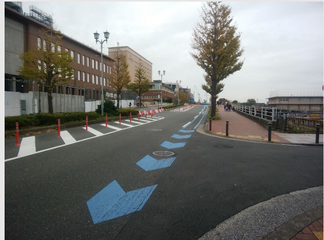
自転車通行空間での路面標示（万国橋通り 中区）
